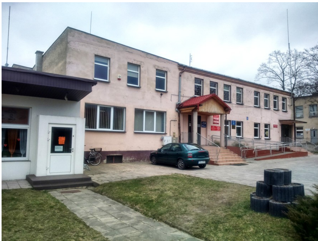
Fot.2. Widok budynku od strony południowej (aut. Szymon Wójcik).
