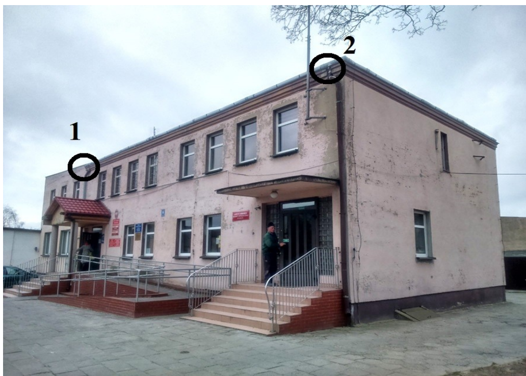
Fot.1. Widok budynku od strony południowej. Nr 1 i 2 oznaczono szczeliny przy rynnach (aut. Szymon Wójcik).
