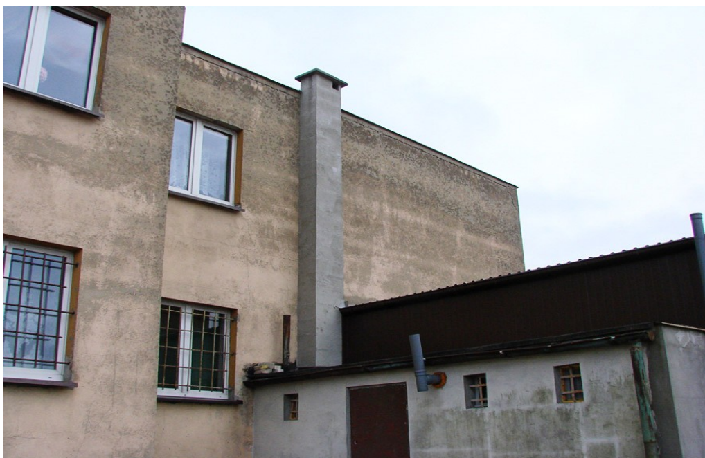
Fot.8. Widok budynku od strony zachodniej (aut. Szymon Wójcik).
