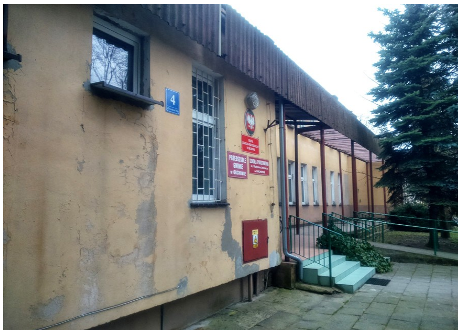
Fot.1. Widok budynku od strony zachodniej (aut. Szymon Wójcik).
