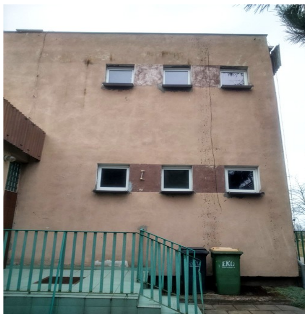
Fot.5. Widok budynku od strony południowej (aut. Szymon Wójcik).
