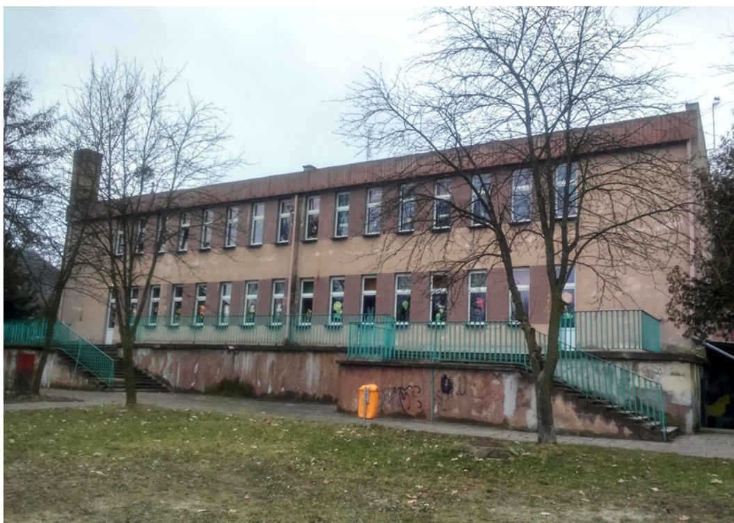
Fot.7. Widok budynku od strony wschodniej (aut. Szymon Wójcik).
