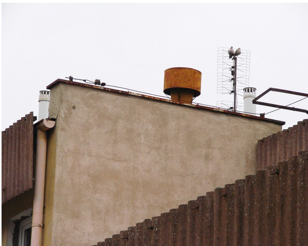
Fot.13. Widok części stropowej od strony południowej (aut. Szymon Wójcik).
