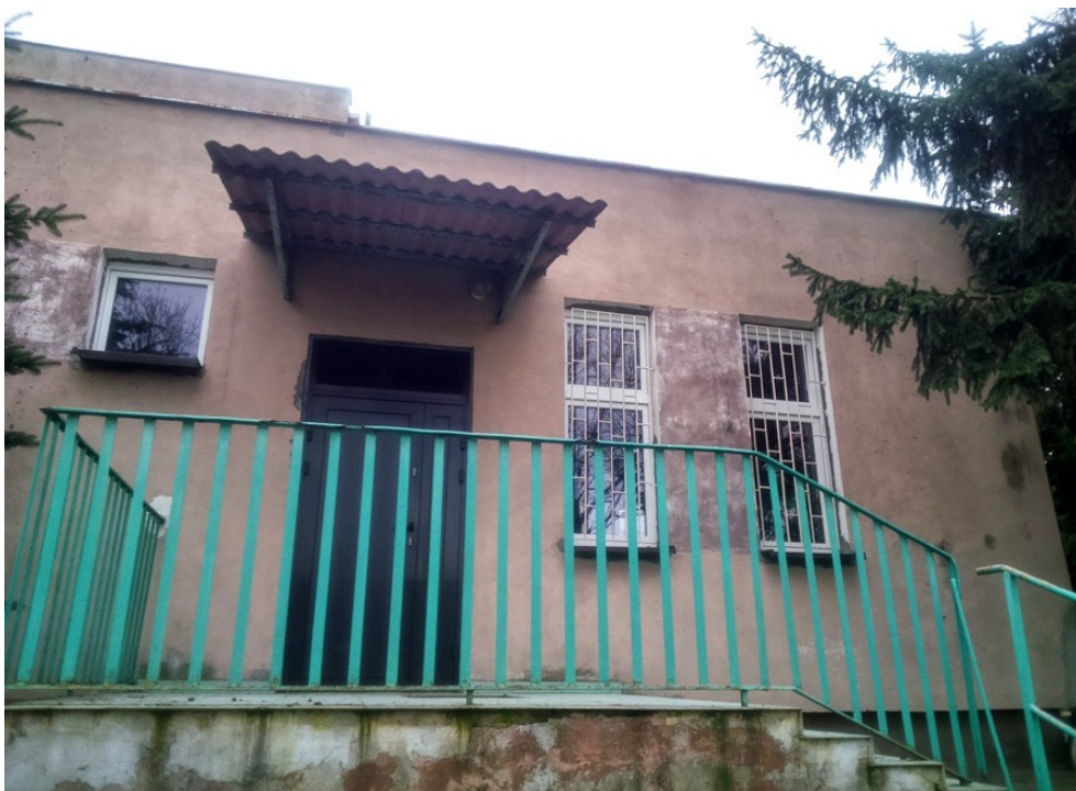
Fot.9. Widok budynku od strony wschodniej (aut. Szymon Wójcik).
