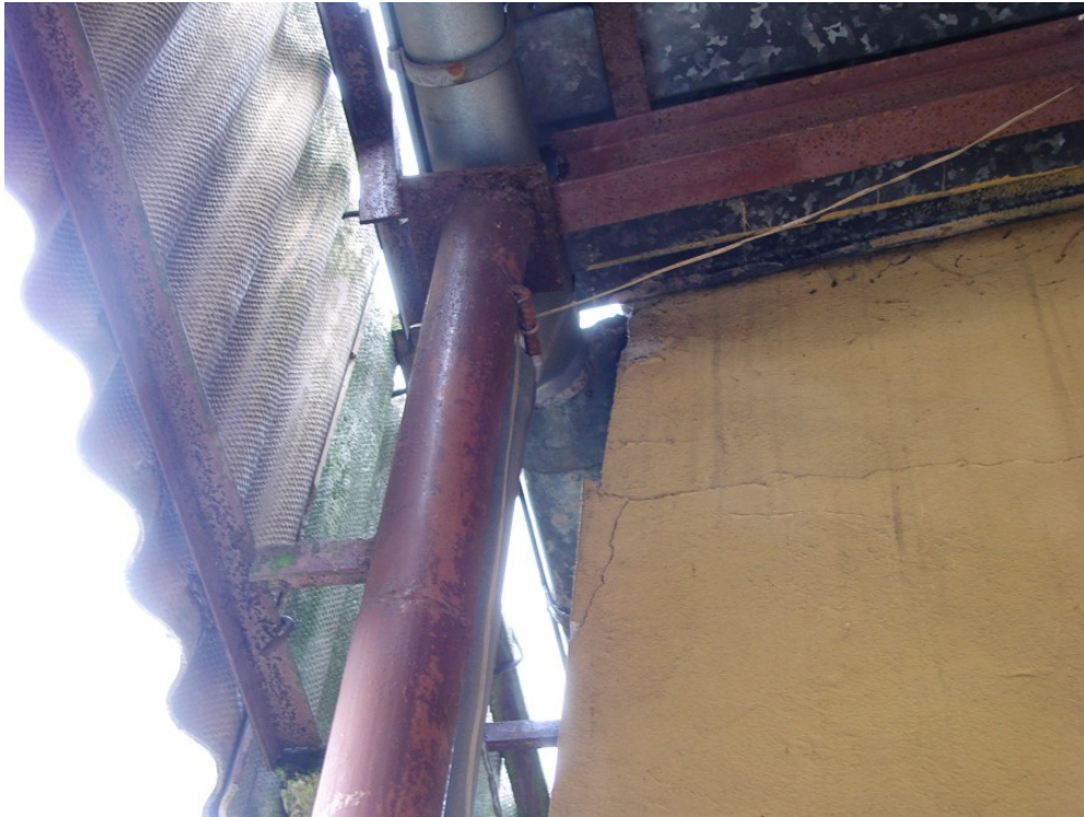
Fot.11. Widok części stropowej od strony zachodniej (aut. Szymon Wójcik).
