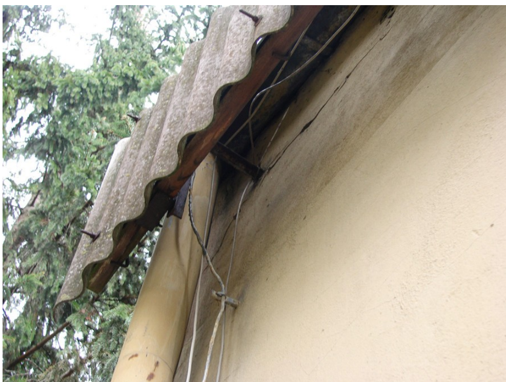
Fot.10. Widok części stropowej od strony zachodniej (aut. Szymon Wójcik).
