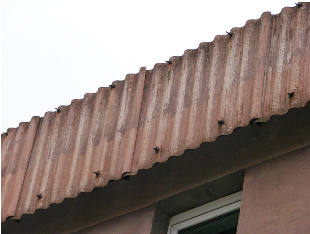
Fot.17. Widok części stropowej od strony wschodniej (aut. Szymon Wójcik).
