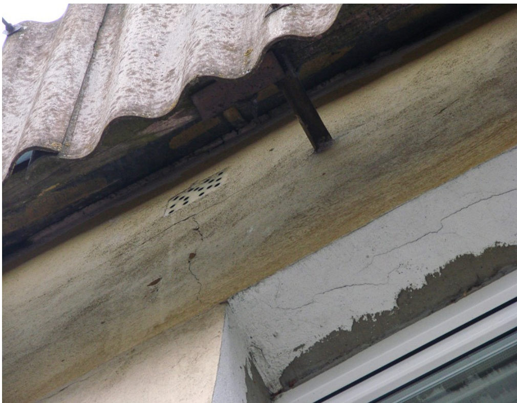
Fot.12. Widok części stropowej od strony zachodniej (aut. Szymon Wójcik).
