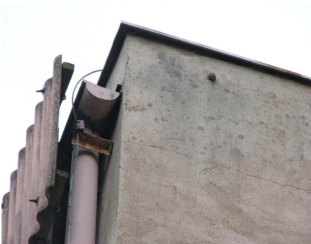
Fot.18. Widok części stropowej od strony północnej (aut. Szymon Wójcik).
